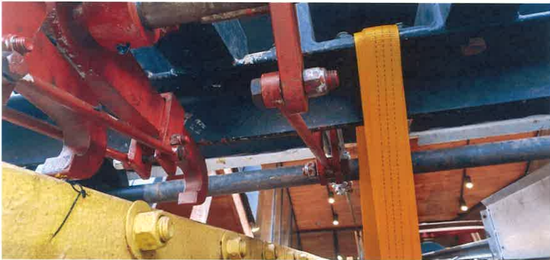
Figura 21: Sistema enclavamiento cabina 1 – Ascensor Cordillera
