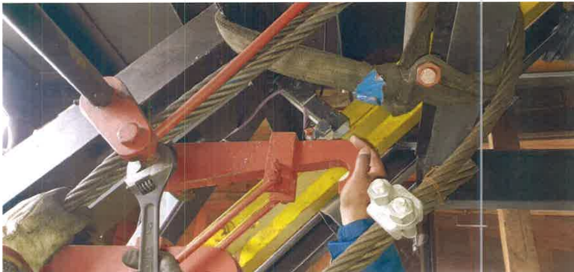
Figura 19: Pernos de la barra de toma (unión ganchos con placa de toma)
