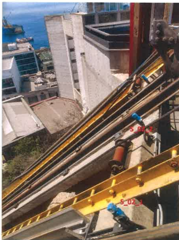
Figura N°9: Sensores de desaceleración.
