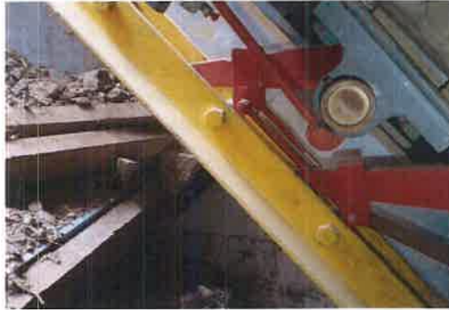
Figura 20: Descenso del gancho, luego de aflojar empernaduras de la barra.
