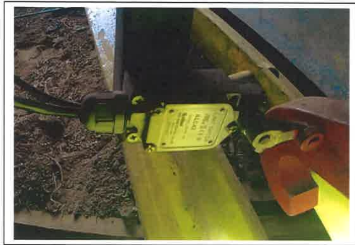
Figura 10: Dispositivo eléctrico de seguridad del sistema de enclavamiento
