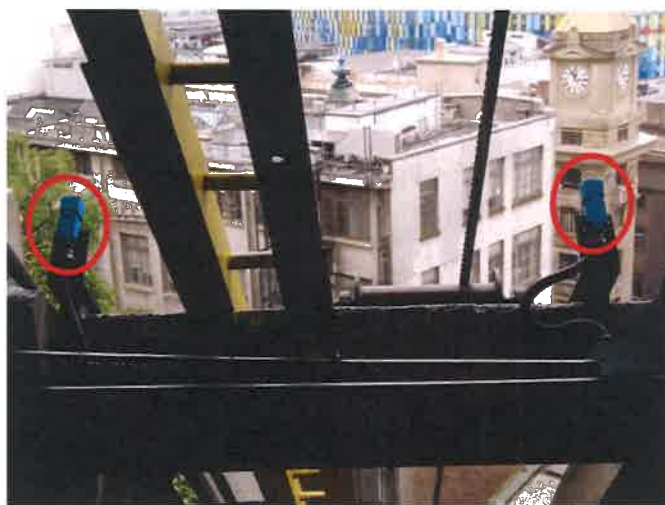
Figura 1: Sensores inductivos de desaceleración
