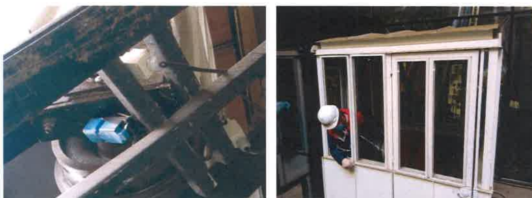
Figura 4 y 5: Cabina 1 (norte) descarrilada e impactada, y cabina 2 (sur) impactada
