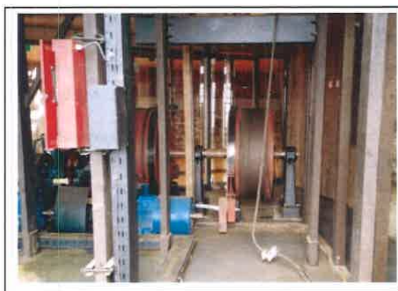
Figura 6: Cable desprendido y estado final de los tambores de enrollamiento (izquierda: cabina 1, derecha: cabina 2).
