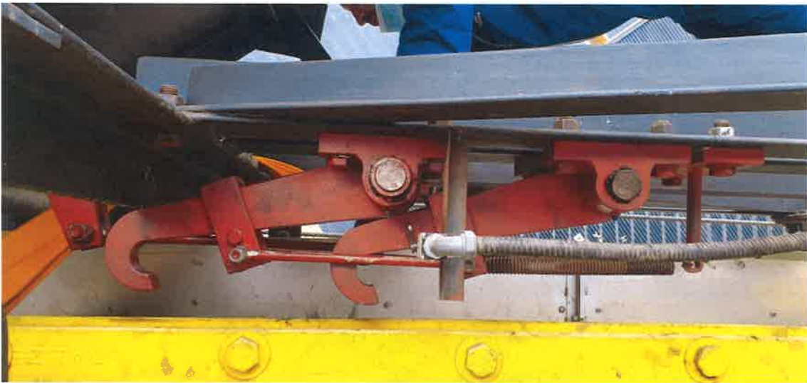
Figura 23: Sistema de enclavamiento cabina 2 – Ascensor Cordillera
