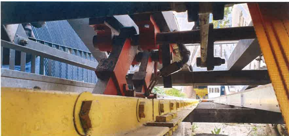
Figura 24: Caída de los ganchos hacia cabina 2, ascensor Cordillera.
