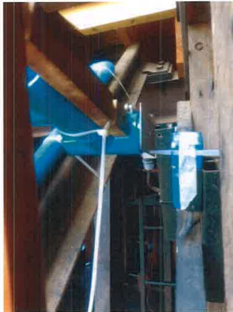
Figura N°17: Simulación del paso del cubo de rueda de cabina frente al sensor de detención.
