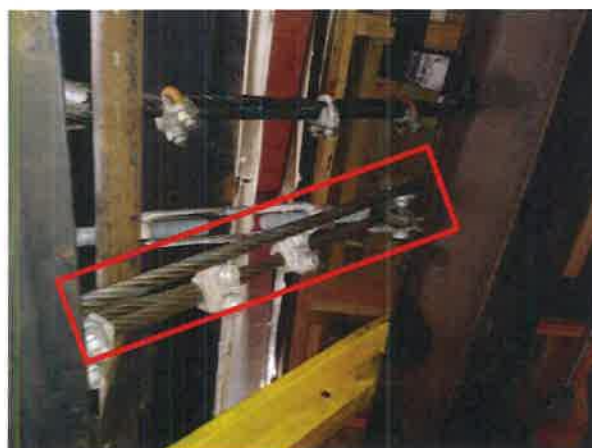
Figura 6: Cable flojo (arrastrado) de la cabina 1 (norte)
