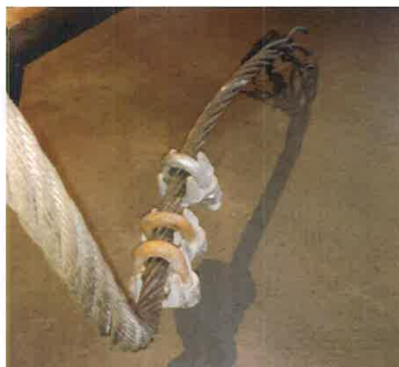
Figura 7: Cable desprendido de la cabina 2 (sur)
