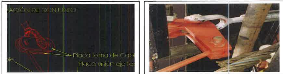
Figuras 2 y 3: Placa proyectada y lo instalado para la toma del cable
