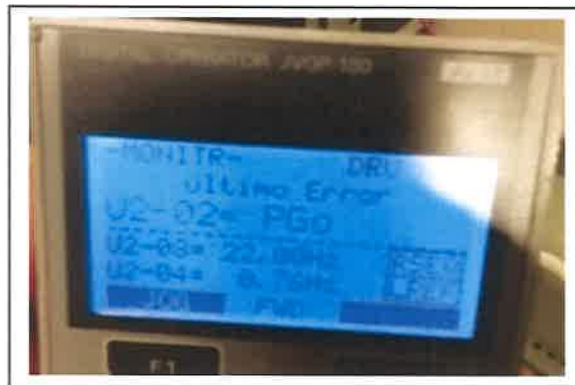
Figura 7: Imagen de error del encoder del variador de frecuencia
